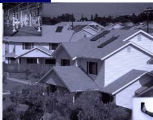
Bâtiments à haute performance
